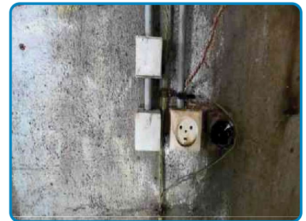
Install. n°1 : Au moins un socle de prise de courant ne possède pas un puits de 15 mm.
