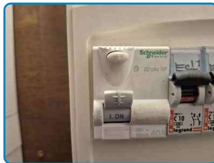
Anomalie B.4.3 j1 sur Install. n°1 (PROTEC.DIFF.)
